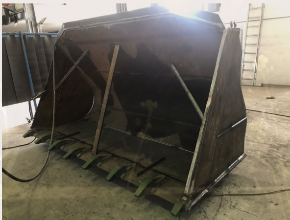
Fertige Rohkonstruktion: Zahnhalter eingehaftet
