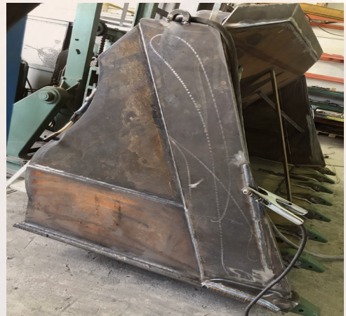
Fertige Rohkonstruktion beim Abschweissen
